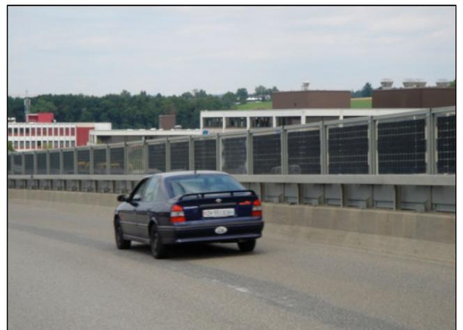
**Abbildung 43 Bi-faziale Solarzellen, vertikal aufgeständert (Bild: Photon)**
