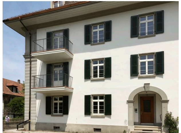
Abb. 31: Der denkgeschützte Windfang durfte nicht erweitert werden.
