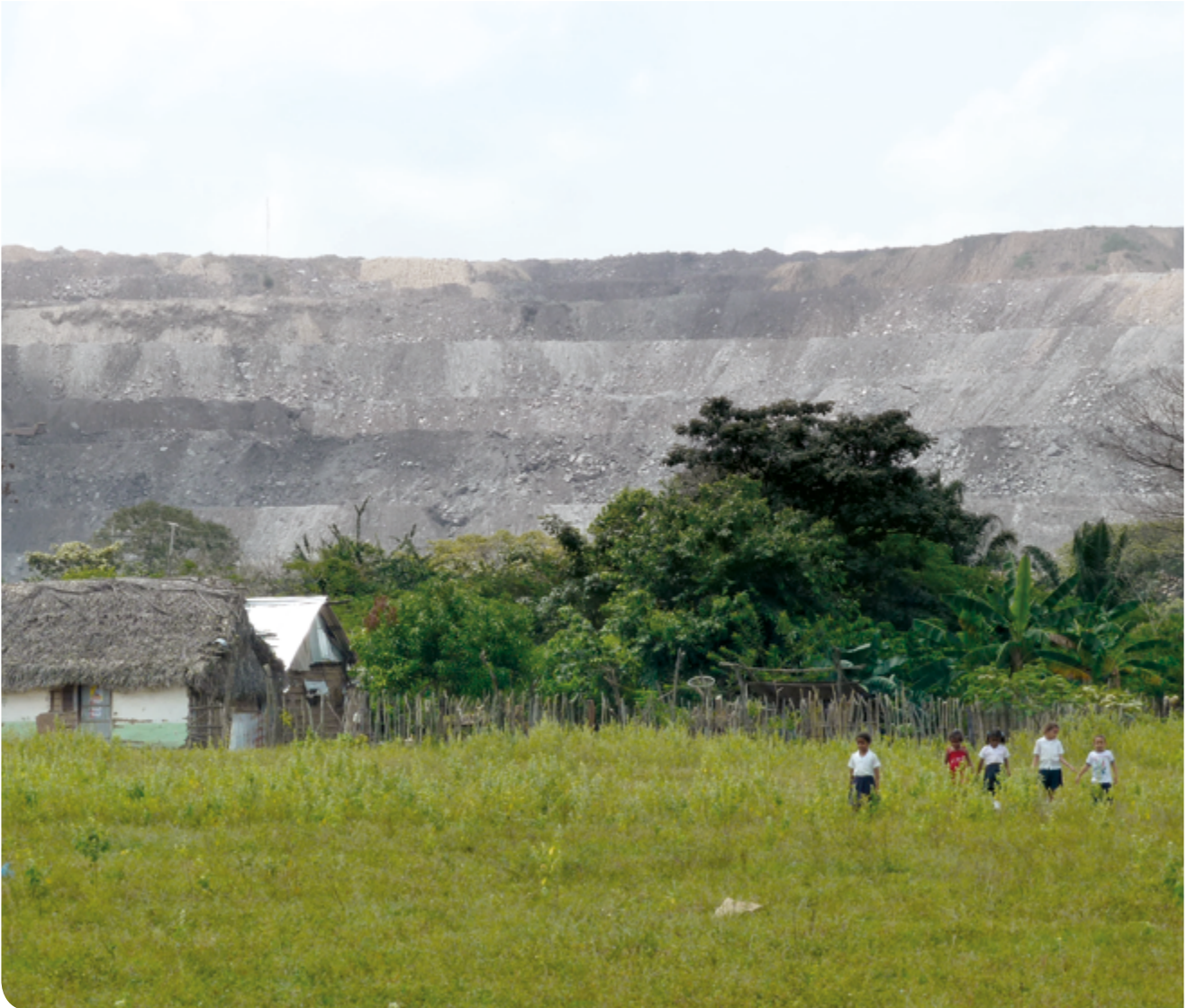
Der Abraam eines Kohlebergwerks in El Hatillo, Kolumbien mit zerstörerischer Wirkung auf Felder und Wald. Gespräche zur Umsiedelung begannen vor sechs Jahren, sind aber immer noch nicht gelöst.
