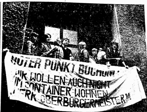
BESETZT VOM „ROTEN PUNKT“, Haus Bergstraße 115. Gerade an der Bergstraße hat sich schon seit Jahren eine Entwicklung abgezeichnet, die großbürgerlichen Bauten der Jahrhundertwende abzubauen und die teuren Grundstücke neu und dichter zu bebauen.
