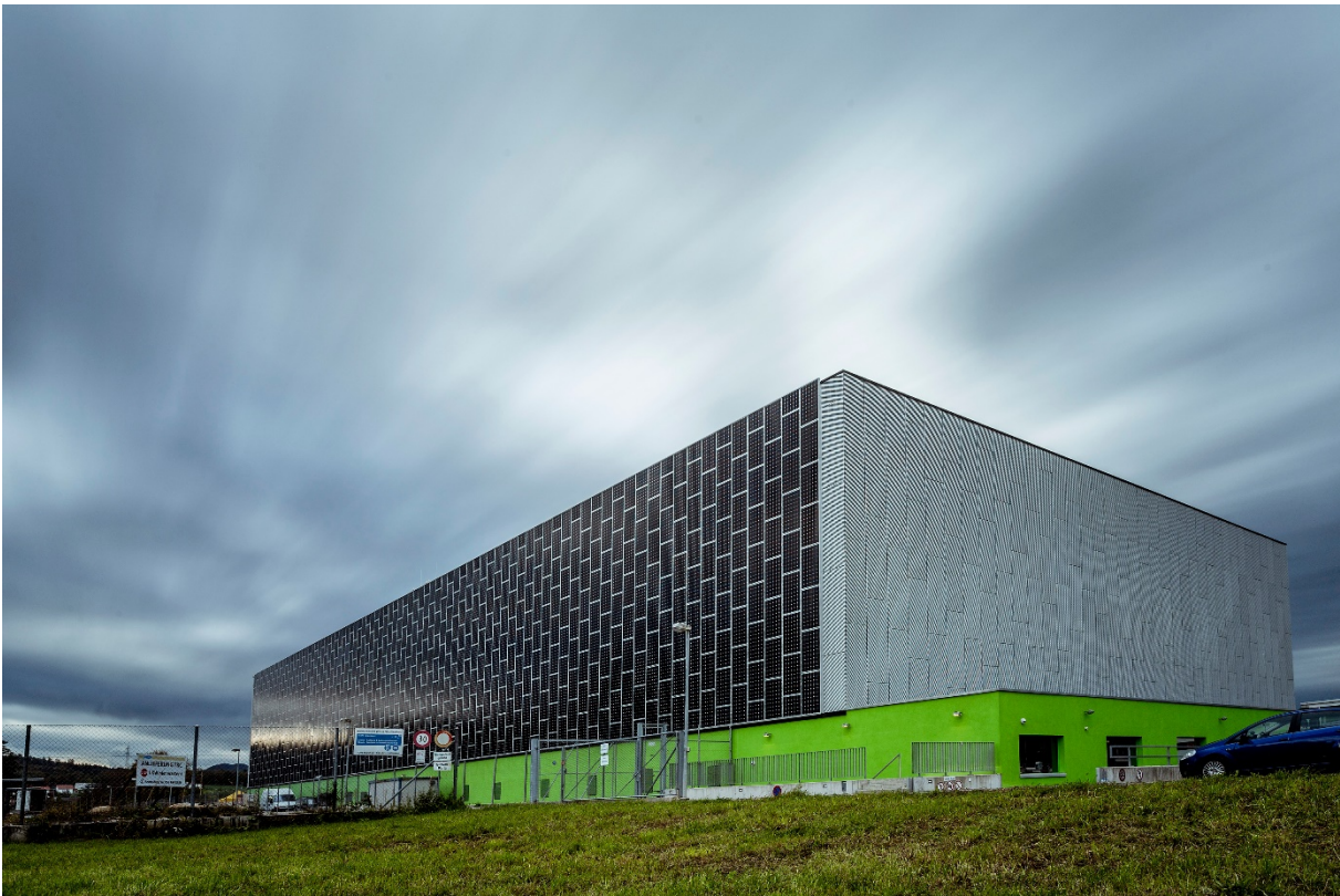
Bildlegende: Green Rechenzentrum mit Photovoltaik-Anlage.
