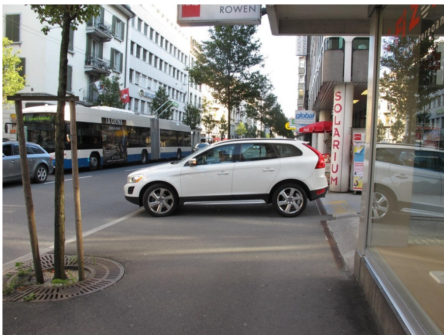
Bild 8: Abschnitt Hirschmattstrasse II, Luzern: Parkplatzzufahrt übers Trottoir
