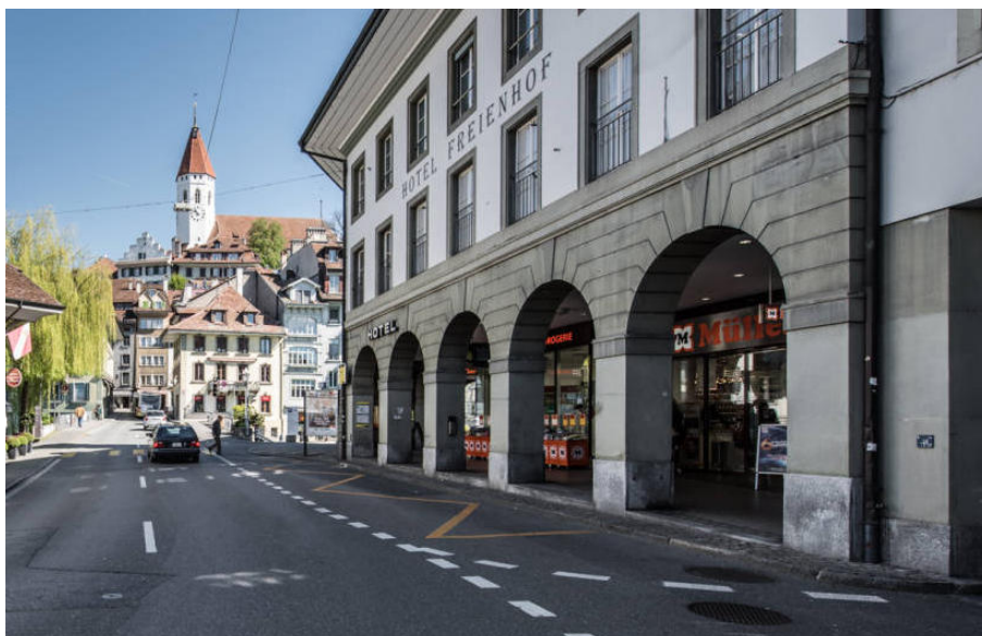
Bild 40: Haltestelle Freienhof; Thun: schlechteste Haltestelle mit einer Treppenstufe und Gebäudestützpfelern an der Haltestellenkante
