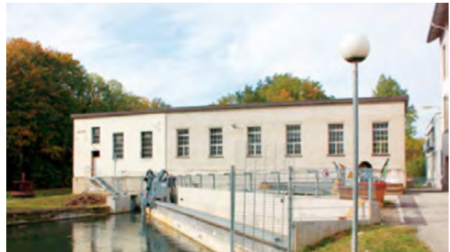
Abb. 48: Das Wasserkraftwerk Stroppe (AG) an der Limmat verfügt über einen Feinrechen, der wandernde Fische bei ihrem Abstieg sicher an den für sie lebensgefährlichen Turbinen vorbeiführt
