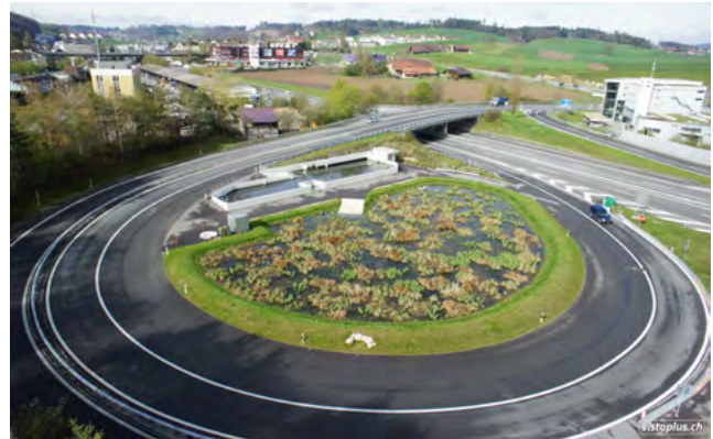
Abb. 38: Strassenabwasser-Behandlungsanlage (SABA) Hallmatt an der A12, Anschluss Niederwangen
