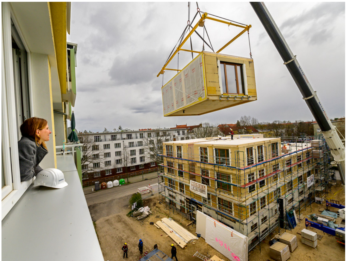
Das Gebäude an der Amendestrasse in Holz-Elementbauweise war in wenigen Tagen aufgerichtet. Foto: Vonovia, Cathrin Bach.
