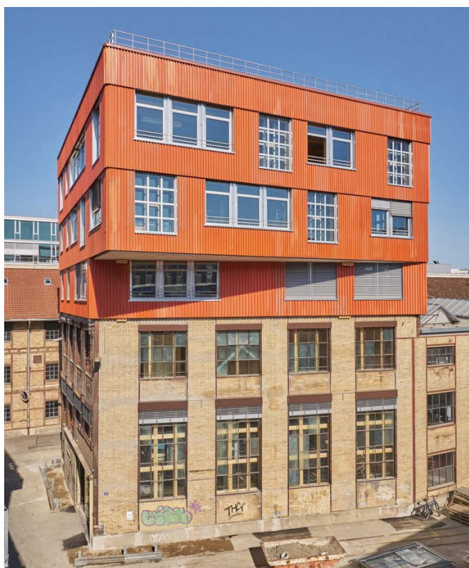
Abbildung 6: Die Aufstockung des Kopfbaus der Halle 118 in Winterthur erfolgte mehrheitlich aus gebrauchtem Baumaterial. (Quelle: baubüro in situ ag 2021, Foto: Martin Zeller)
