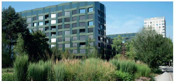
Schlieren, am Rietpark: Naturnah gestaltete Geländeunebenheiten eignen sich dazu, nach Niederschlägen Regenwasser zu sammeln und zu versickern.
