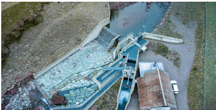
Kraftwerk Schils mit neuer Wasserfassung, für Fische und Sedimente passierbar. © SAK
