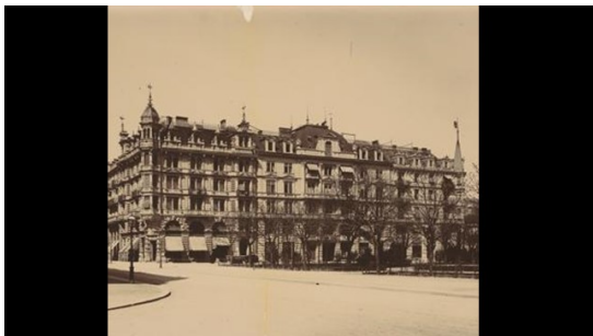
Bild 25: Wohn- und Geschäftshaus in Zürich
