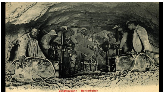
Bild 36: Bau im Tunnel
